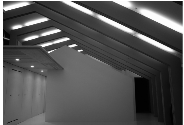
図6 Ocha House 内観写真 (フレームに設置された LED 間接照明が天井を照らす)
