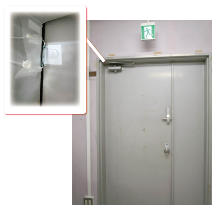
図 9. 研究室のドアにリードスイッチを取り付けた
